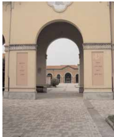
Pavimentazione con autobloccanti al cimitero
