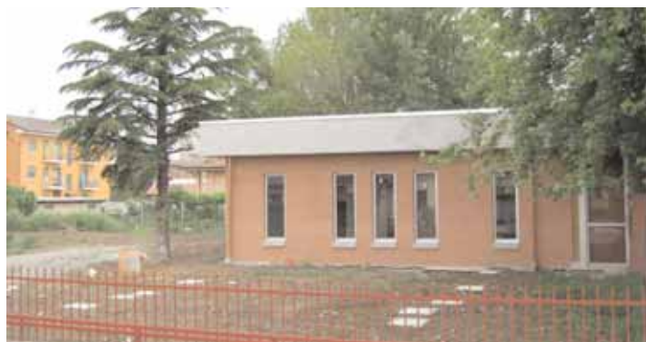
Costruzione nuovo locale presso l'asilo
