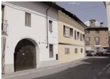
Progetto ristrutturazione Largo Butteri vista da via Tortona
