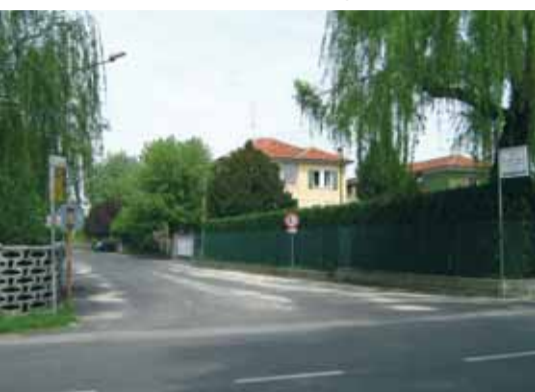
asfaltatura di strada Valle
