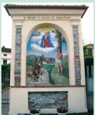
Appena terminata da parte della famiglia Lunassi la ristrutturazione dell'antica edicola
