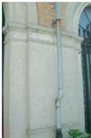
Rifacimento grondaie cimitero
