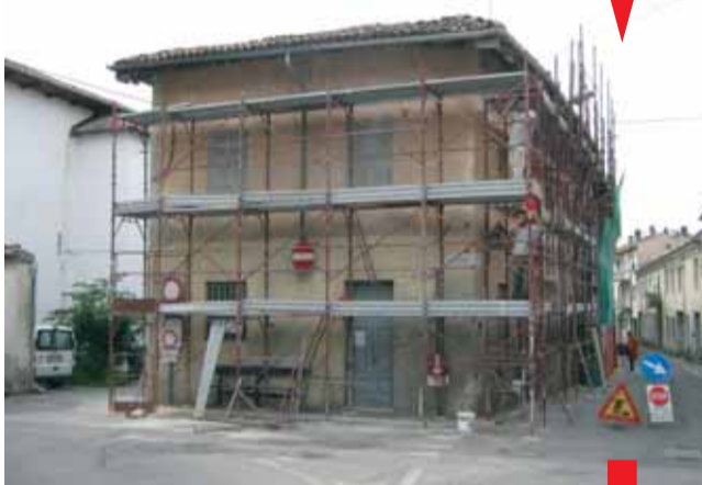
Lavori biblioteca via Arzani
